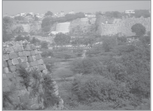
Photo 8 Nouvelles constructions dans le fort de Tughluqabad (photo HJ, décembre 2010)
