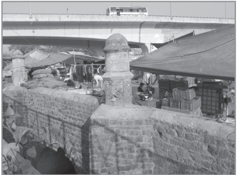
Photo 14 Route surélevée construite sur Barahpula (photo HJ, décembre 2011)
