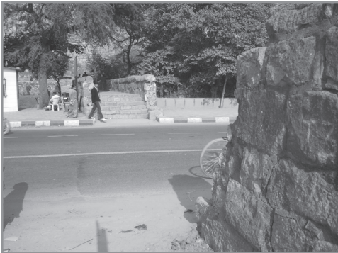
Photo 13 Chaussée démolie pour la construction d'une route à Tughluqabad (photo HJ, décembre 2010)
